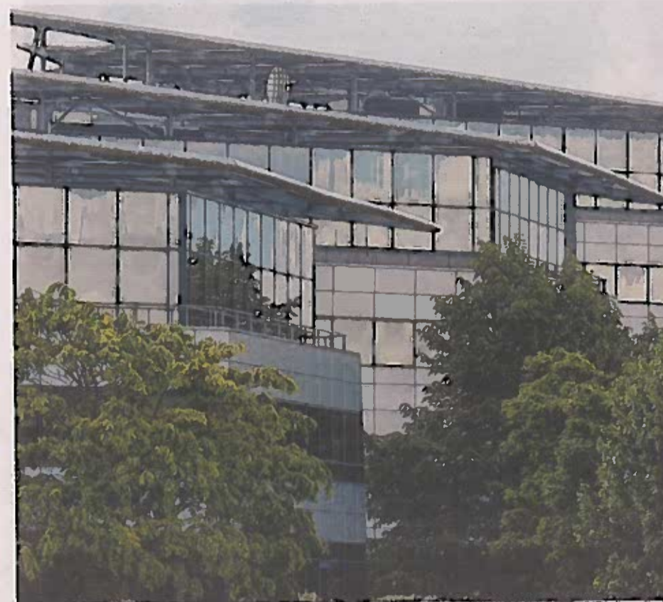
BUREAUX. La technopole propose 270.000 m 2 de bureaux aux entreprises et start-up.
